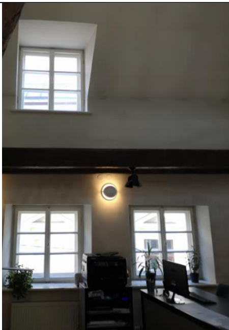
28. attēls . Koka logi, skats no fasādes 29. attēls . Koka logi, skats no iekštelpām
