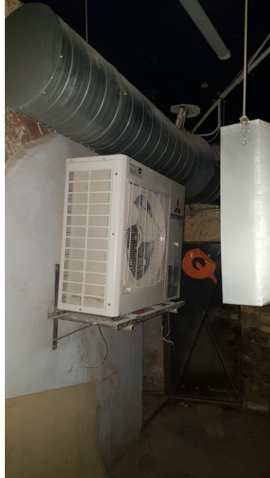
57. attēls. Kondicionieru ārējais bloks
