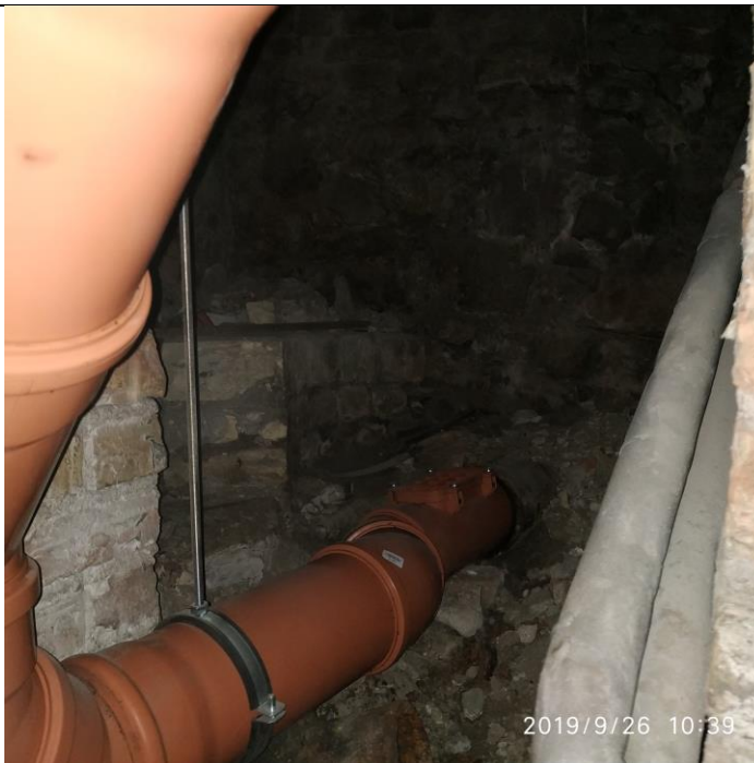
43. attēls. Kanalizācijas izvads.
