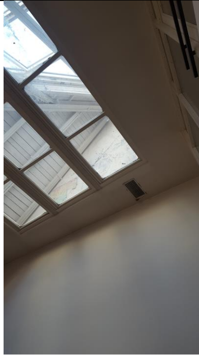
55. attēls. Ventilācijas reste 2.stāva griestos
