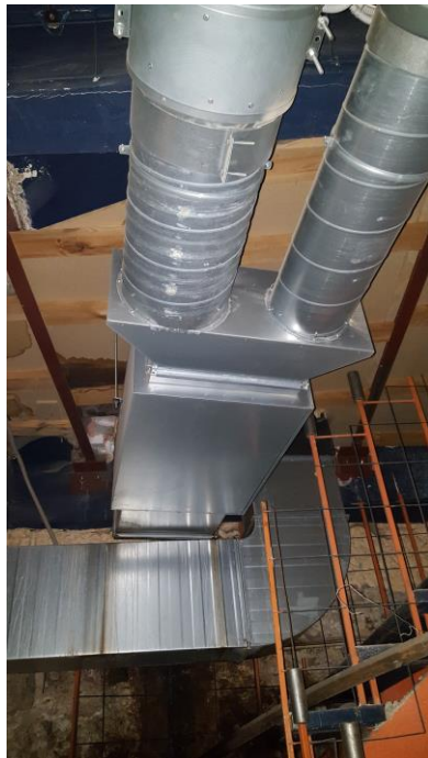
56. attēls. Ventilācijas iekārta pagrabā
